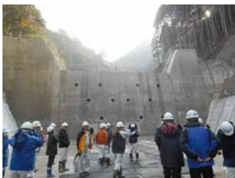
12月6日に産業建設常任委員会で栗平土砂ダムの視察を行いました。
